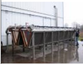
Die perfekte Freikühlung Trockenkühlsystem EDK System: Ecodry-Tec
